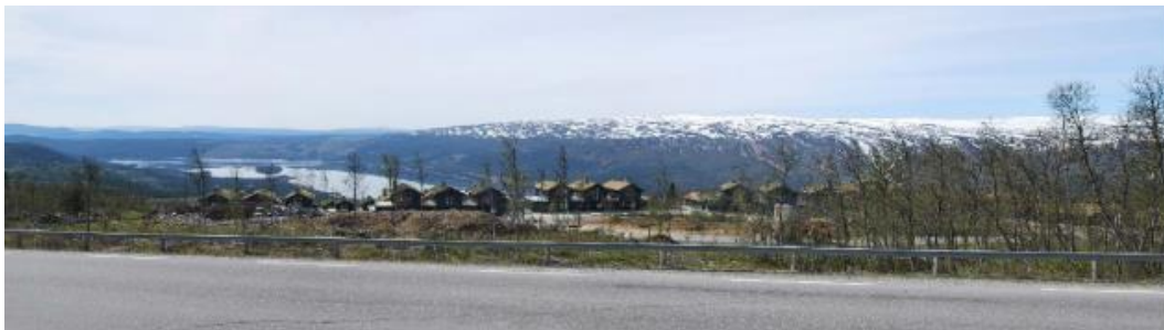
Dagens situasjon. Foto fra gangveien nord for planområdet. Utsikt mot Aasgarden byggetrinn 1 og 2 og utsyn mot Øyangen og Slettefjell. Kilde: Deltema Landskap, fig. 3.1.
